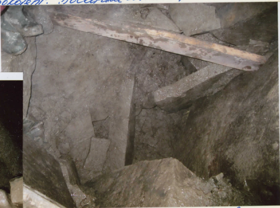
ZABEZPEČENÝ PRŮLEZ, NA SPODNÍ PATRA ČERTÁKU
