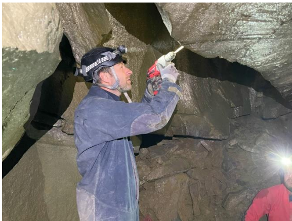
Roman instaluje (poprvé) kotevní nýt
