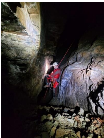
13 Místo instalace kotevního bodu (hloubka okolo 35 metrů)
