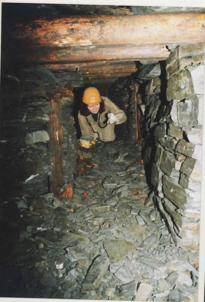
PŘÍSTUPOVÁ CHODBA OD ŠACHTY - 40 m.
