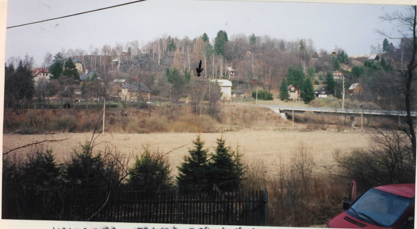
HALDA NAD VESNICÍ ZÁLUŽNĚ SE VSTUPY DO PODZEMÍ - ↓ NOVĚ OBJEVENÝ VSTUP NA III PATRO
