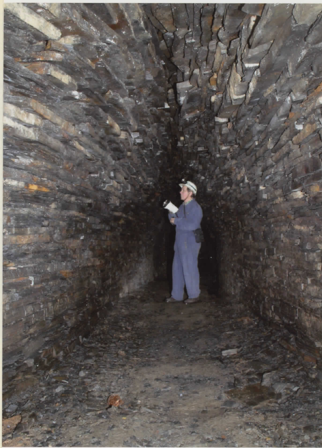
CHODBY DOLU STARÝ ŠIFRAKŮ, ZAPLAVOVANÉ VODOU...
