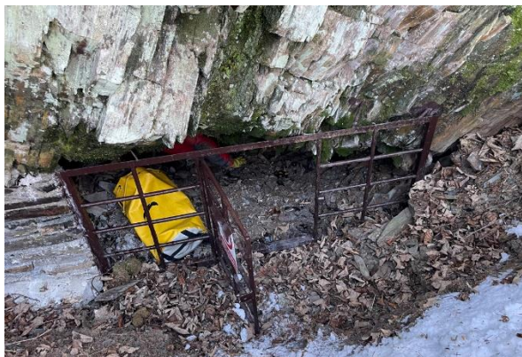
Opravený vstup do Zálužné Dobývka A
